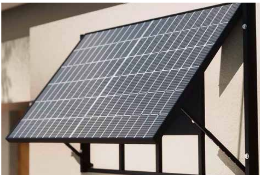
Die schräge Montage verbessert den Ertrag geringfügig. Das Paneel wirkt aber wie ein Segel und übt bei Wind eine hohe Last auf die Balkonbrüstung aus. Foto: pixabay
