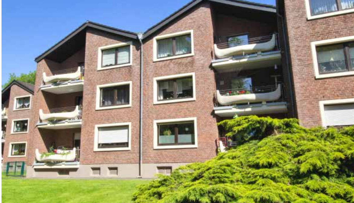
Oben: Erstrahlen wieder sauber und hell: GBB-Häuser in Batenbrock.
