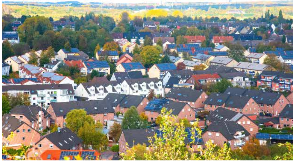
Blick vom Alpin-Center: Auf in der Stadt verteilt insgesamt 150 Dächern der GBB (Bild) befinden sich Photovoltaikanlagen von verschiedenen privaten Investoren und der GBB selbst, die im Jahr 1.978.000 Kilowattstunden erzeugen.
